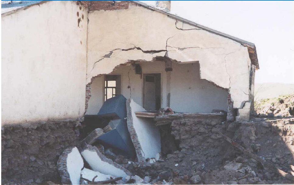
Şekil-3.3 Gevşek zeminli duvar altı hatılsız bina (YDGA-2005)
