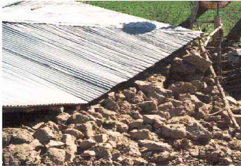
Şekil-3.11 Moloz taşlar arasındaki çamurlar ıslakken bağlayıcı özellik göstermesine karşın kuruyunca bu özelliğini kaybeder.( YDGA-2005 )
