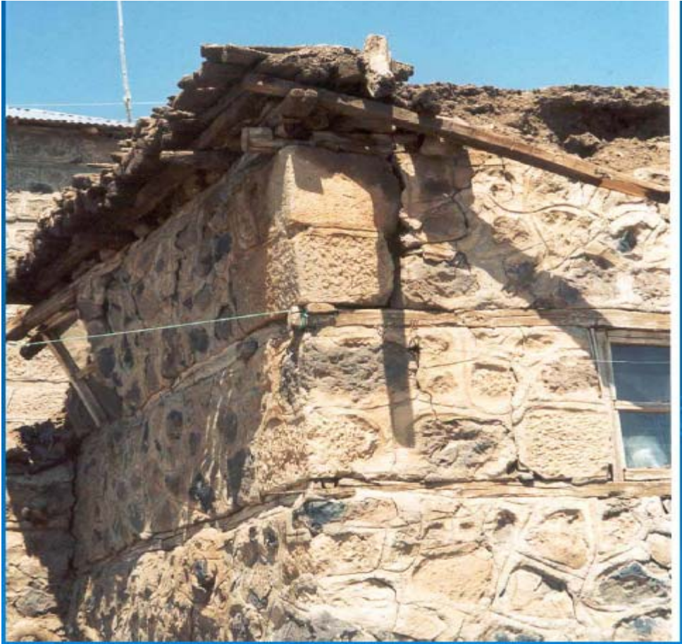
Şekil-3.10 Kırsal kesimde bulunan ağır toprak damlı bina(YDGA-2005)
